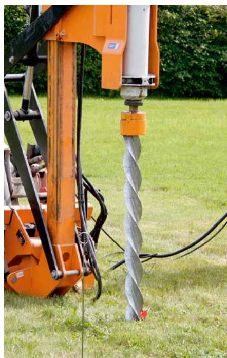
Einrammen der Gewindepfähle Pile-driving
