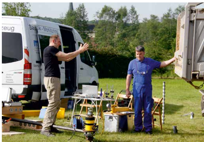
Pfahlprobelastung im Versuchsfeld | Pile load test in the test area
